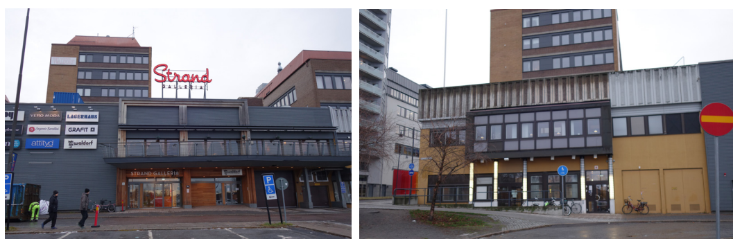
Figur 11 Bild mot Strand galleria taget från Trekanten parkering. Bild till höger visar stödmur och ramp mot Smedjegatan.
